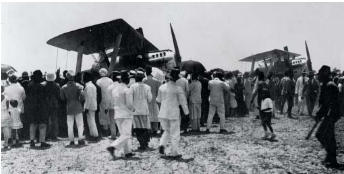
Aspecto da entusiástica recepção à chegada dos aviadores a Inhambane, em Moçambique
