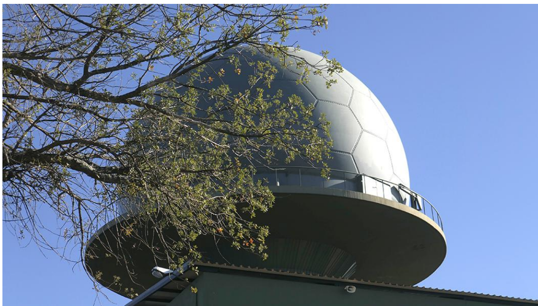
Imagem 7: Radome da antena.
