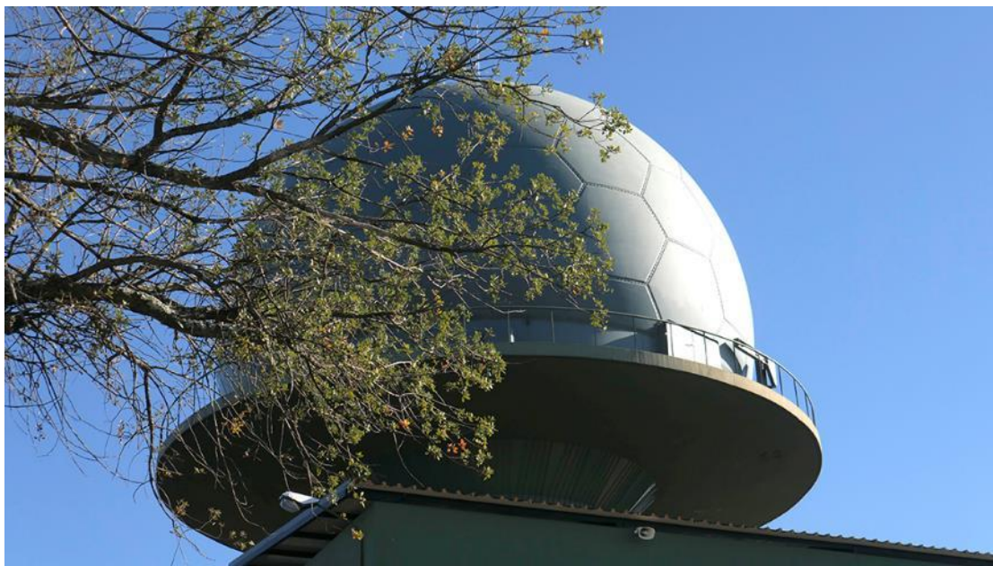
Imagem 7: Radome da Antena
